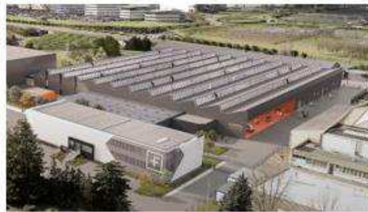
Forsee Power opère sur 2 sites en France (Ivry-sur-Seine et Chasseneuil-du-Poitou)
